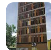
20 HQ Tower Oficinas 2017
