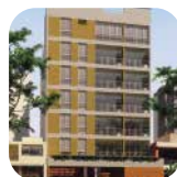
13 Edificio Albano Departamentos 2013
