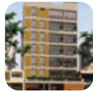
13 Edificio Albano Departamentos 2013
