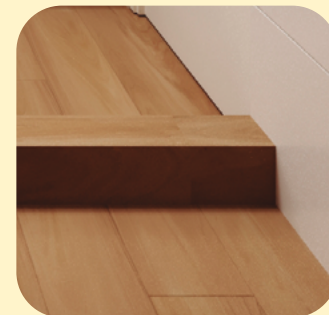
Detalle de piso mayólica
