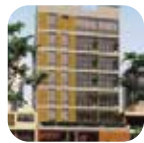
13 Edificio Albano Departamentos 2013
