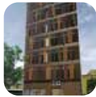
20 HQ Tower Oficinas 2017
